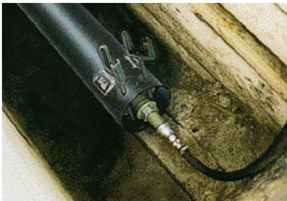
Einbau des Rohrstopfens zur Säuberung des Stahlrohres
