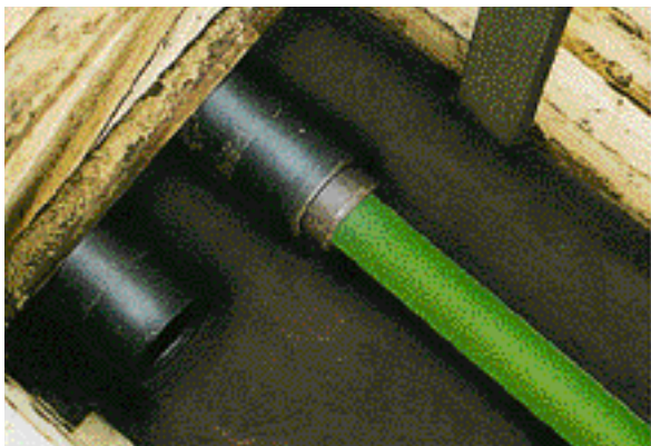
Stahlrohrvortrieb parallel DN 250 mm, 24 lfd. m unter Bahndamm
