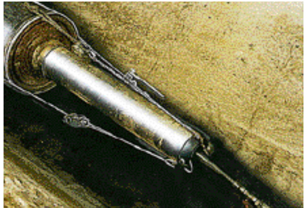
Stahlrohrvortrieb DN 1000 mm, 25 lfd. m
