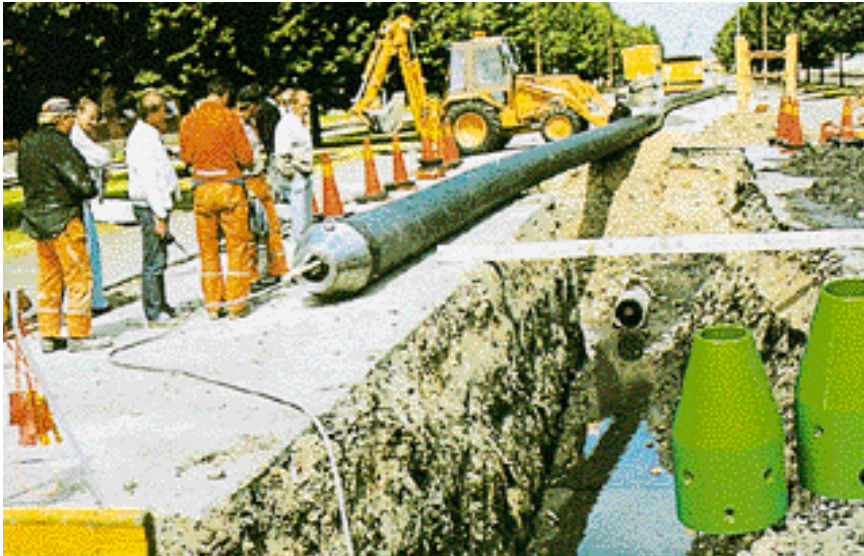
Betonrohr 400 mm \phi , Einzug HDPE-Rohr 560 mm \phi , Vorbereitung zum Start
