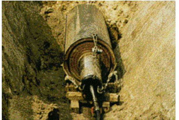
Stahlrohrvortrieb DN 1200 mm, 22 lfd. m
