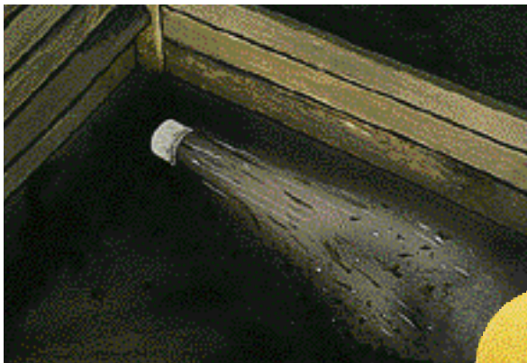
Einbau des Rohrstopfens zur Säuberung des Stahlrohres
